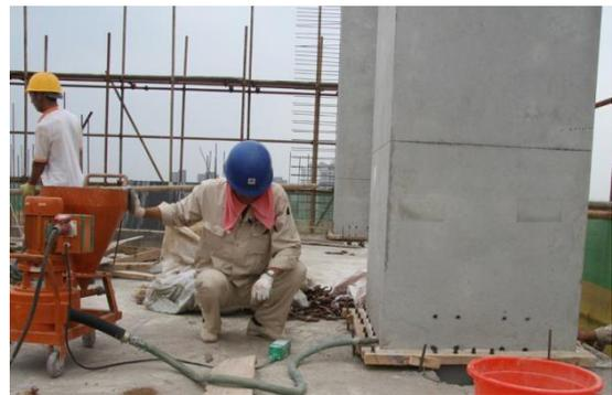
图4 预制剪力墙套筒灌浆施工
