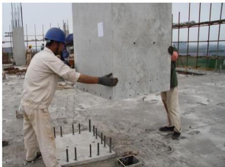
图3 预制柱吊装施工
